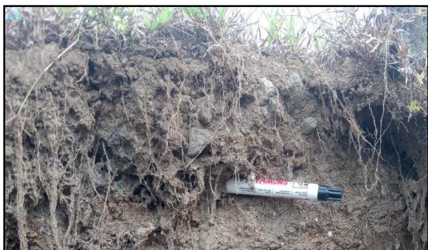
Gambar 6. Penampakan zona derajat pelapukan V
