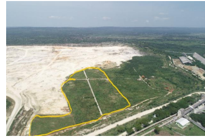
Gambar 3. Realisasi penutupan tajuk di blok E, F dan G pada tahun 2019
