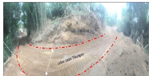
Gambar 2. Lebar jalan aktual pada jalan menikung
