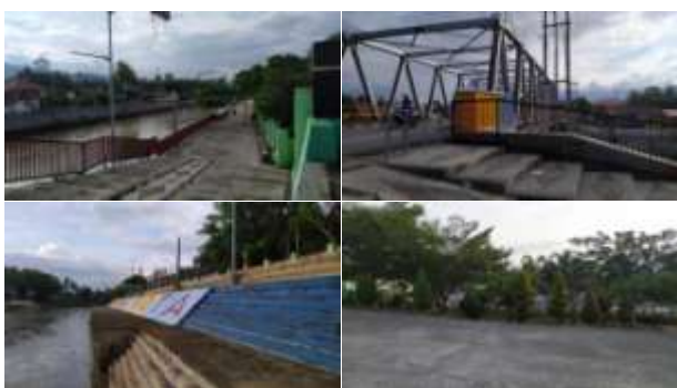
Gambar 6. Keadaan dan Fasilitas Lokasi Pertama di Bantaran Samping Lapangan Merdeka; a) Sidewalk , b) Jembatan Samping Lapangan Merdeka, c) Laydam , d) Vegetasi di Taman Sekitar Sumber: Dokumentasi Penulis, 2022
