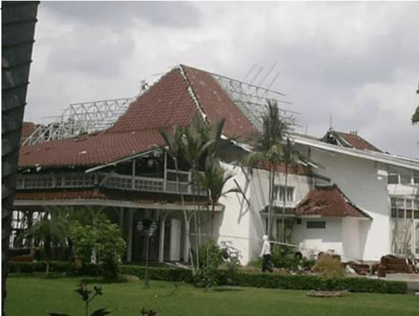
Gambar 15. Renovasi Bagian Atas Rumah Dinas Walikota Palembang Sumber: Kota Palembang, 2008
