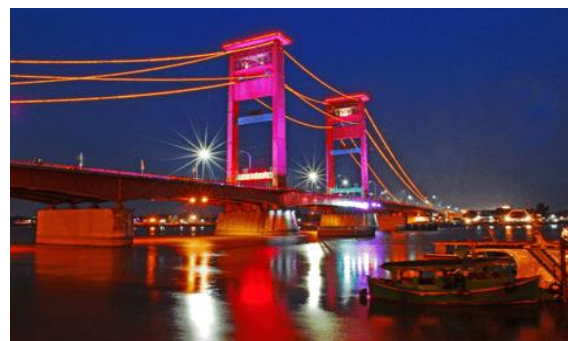
Gambar 1. Jembatan Ampera Kota Palembang Sumber: Palembang.go.id, 2021
