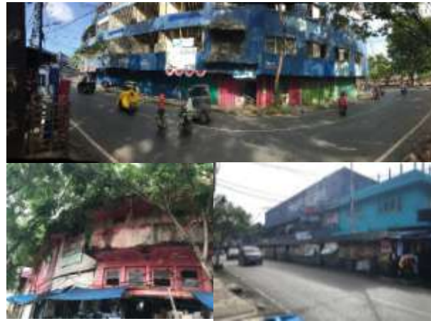
Gambar 24. Bangunan Lama Bergaya Kolonial Kawasan Pasar Sudimampir Sumber: Dokumentasi Penulis, 2023
