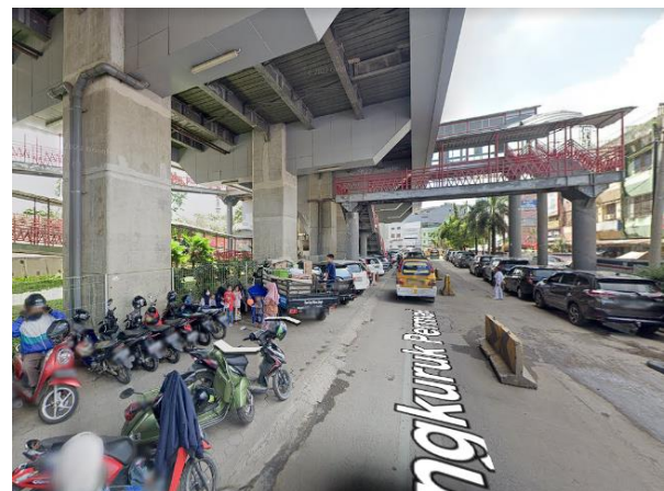
Gambar 9. Kondisi koridor jalan di sekitar Stasiun LRT Ampera
