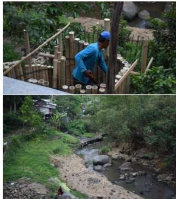
Gambar 10. Halaman Depan Serlok Bantaran pada Masa Pembangunan Sumber: Dokumentasi Penulis, 2019
