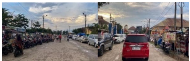
Gambar 6. Kondisi Jalur Pejalan Kaki Sumber : Dokumentasi Penulis, 2024
