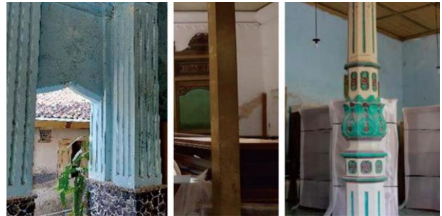
Gambar 5. Model Kolom Batu Menyerupai Pilar dan Saka Guru Kayu dengan Ukiran yang Indah Sumber : Dokumentasi Penulis, 2021
