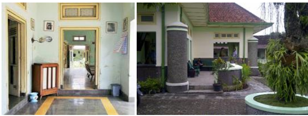
Gambar 8. Kiri, Ornamen pada Pintu dan Bovenlicht dari Area Pendapa menuju Dalem; Kanan, Kolom seperti Pilar Berbentuk Lingkaran Dilapis Batu Granit Sumber : Dokumentasi Penulis, 2021
