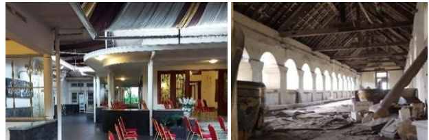
Gambar 11. Kiri, Kolom Beton Bulat Penyanggah Dak Beton di Teras yang Melengkung; Kanan, Bangunan Loteng Menggunakan Konstruksi Kuda-kuda Kayu Sumber : Dokumentasi Penulis, 2021
