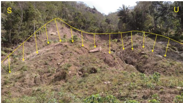
Gambar 11 Lokasi pengamatan longsor 1 (Azimuth Foto: N 252°E)
