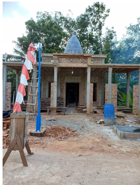
Gambar 2 Dokumentasi pemasangan tiang PLTS di desa Dabuk Rejo
