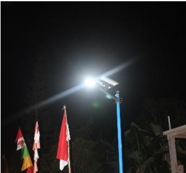
Gambar 3 Dokumentasi pengujian komponen sensor PLTS
