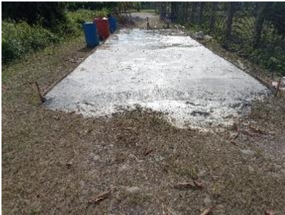
Gambar 11 Hasil sementara perkerasan jalan
