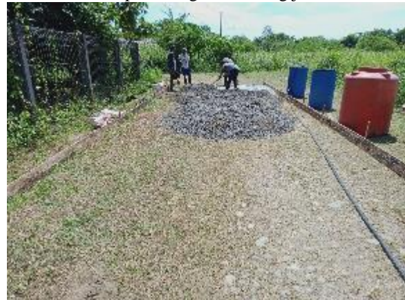
Gambar 9 Proses pencampuran material
