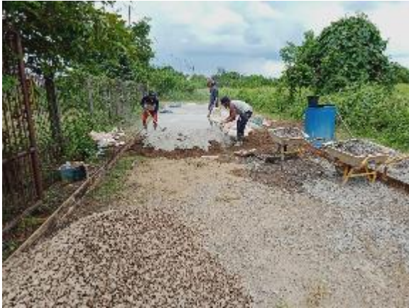
Gambar 10 Proses pencampuran material SCC
