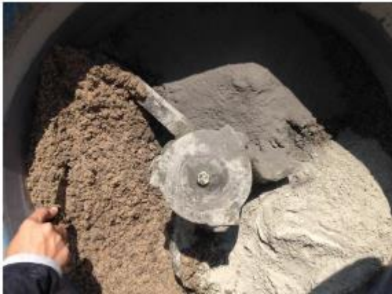
Gambar 4 Proses pencampuran semen
