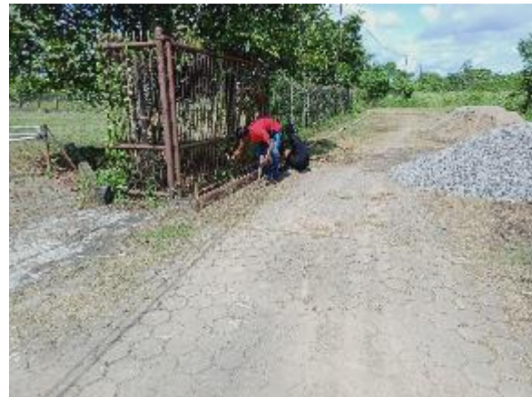
Gambar 8 Proses pemasangan bekisting jalan
