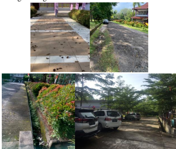
Gambar 4. Kondisi Tata Bangunan Luar
