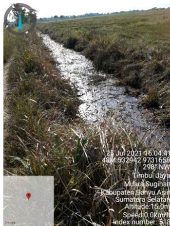
Gambar 3. Kondisi Saluran Tersier
