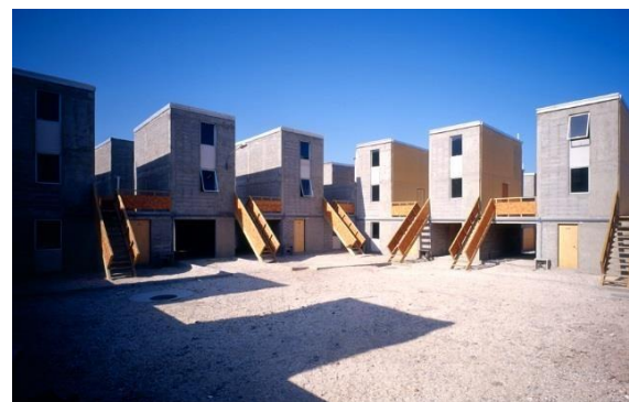
Gambar 1. Konsep pembangunan Half Good House
