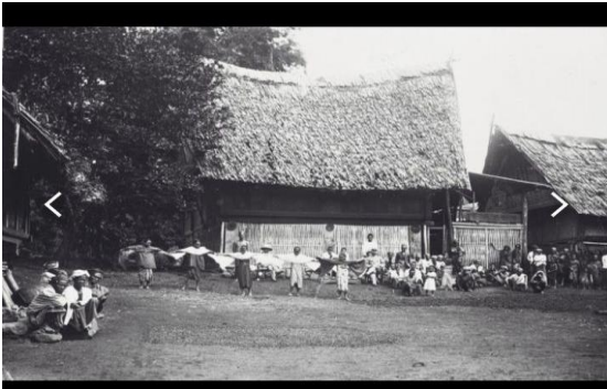
Gambar 1 tampak rumah baghi
