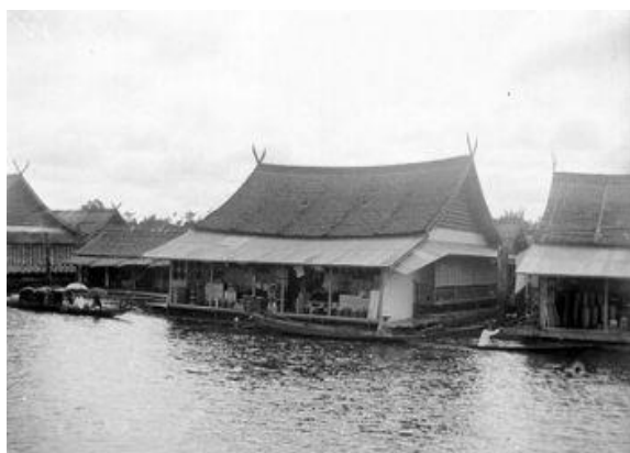
Gambar 5 tampak rumah baghi
