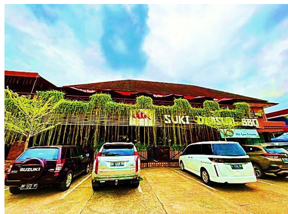
Gambar 4.3. Dokumentasi Tampak Depan Tanaman Lee Kwan Yew Pada Gedung Kopitiam dan X.O Suki Dimsum Palembang, Indonesia.. (Sumber: Kopitiam dan X.O Suki Dimsum Palembang)
