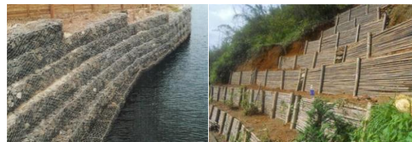
Gambar 13 Ilustrasi Pemasangan Bronjong dan Bambu Penahan Tebing
