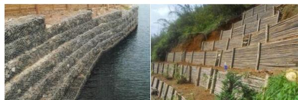
Gambar 13 Ilustrasi Pemasangan Bronjong dan Bambu Penahan Tebing
