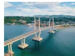
Jembatan Merah Putih di Ambon
