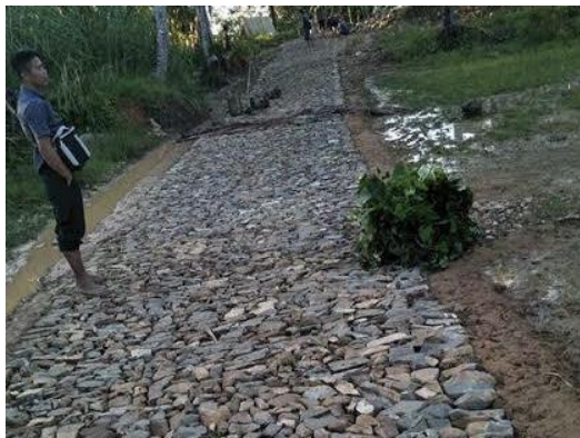
Gambar 19. Penggunaan batu belah untuk jalan Sumber: Zonariau, 2018
