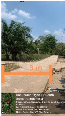
Gambar 11. Lebar Jalan Cor Beton di Desa Suka Mulia Dusun 3
