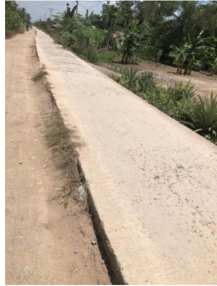
Gambar 12. Jalan Setengah Beton, Setengah Tanah Diolah Oleh Penulis, Tahun 2023
