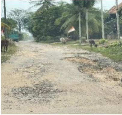
Gambar 5 : Jalan akses utama desa Tanjung Lalang
