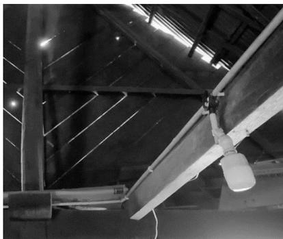
Gambar.22 Struktur jambat tikus pada rumah baghi (Dokumentasi pribadi, 2020)
