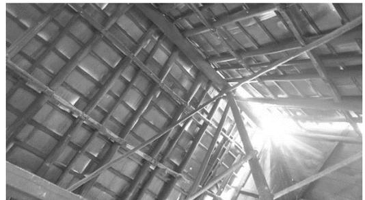
Gambar.24 Kerangka struktur mubungan pada rumah baghi (Dokumentasi pribadi, 2020)
