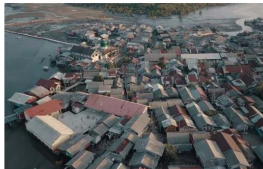
Gambar 1. Kondisi Eksisting Permukiman Desa Telaga Tujuh Pusong
