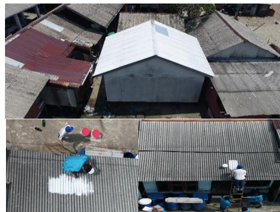
Gambar 5. Proses pengecatan pada atap rumah di kawasan pesisir Pusong.
