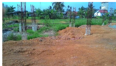
Gambar 1 Kondisi pembangunan terakhir masjid saat ini (sumber: dokumentasi pribadi, 2020)
