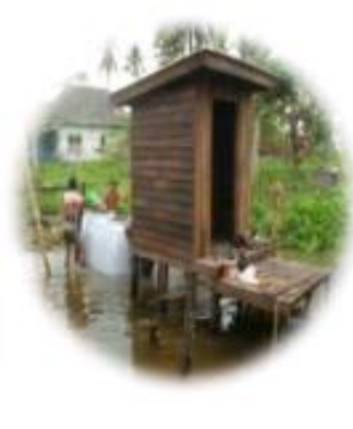
Gambar 6 Pengolahan air limbah sistem Biofilter dan taman Sanita Terapung
