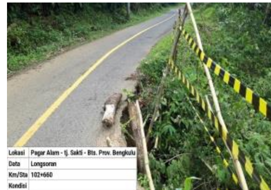
Gambar 2 Longsor pada ruas jalan Pagar Alam – Tanjung Sakti – Batas Provinsi Bengkulu
