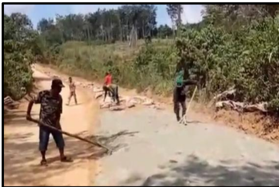
Gambar 4. Kegiatan Penghamparan Semen Sesuai dengan Jarak yang Telah Ditentukan
