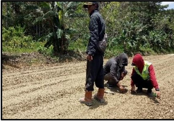
Gambar 7. Pengambilan Sampel untuk JMF
