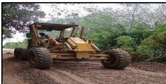
Gambar 1. Kegiatan Penghamparan Material Baru berupa Agregat Kelas A
