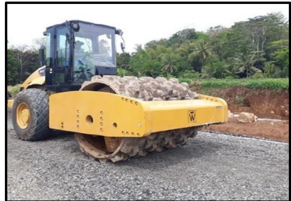
Gambar 6. Pemadatan Menggunakan Pad Foot Roller
