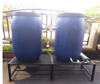
Gambar 2. Rancangan Instalasi Penjernih Air
