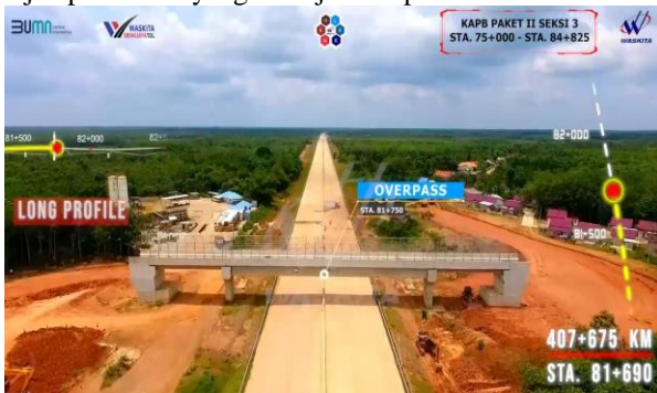
Gambar 1. Lokasi Jembatan Jalan ( Overpass ) Sta. 81+750
