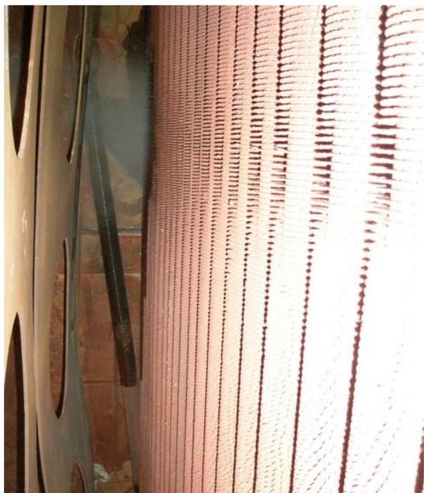
Gambar 1. Kondisi pipa yang bengkok terdampak gaya dorong dari kebocoran
