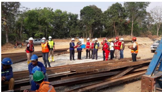
Gambar 5. Inspeksi oleh KKJTJ Sebelum Pelaksanaan Launcher Girder
