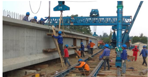
Gambar 13. Bracing pada Girder PC-I H-230
