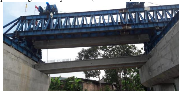
Gambar 14 Posisi Girder di Atas Bearing Pad
