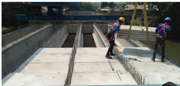
Gambar 16. Instalasi Lantai Jembatan
