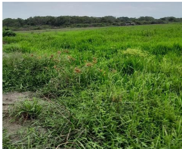
Gambar 3. Kondisi gorong-gorong yang ditutupi rumput
