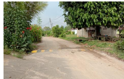
Gambar 7 Lokasi II pembuatan speed hump di Jl.Tanjung Bubuk
