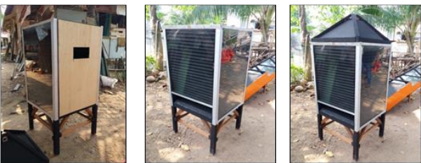
Gambar 5. Pemasangan Kaca pada Ruang Pengering
