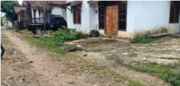
Gambar 6 Beberapa blok perumahan tidak terdapat saluran drainase atau air kotor.
