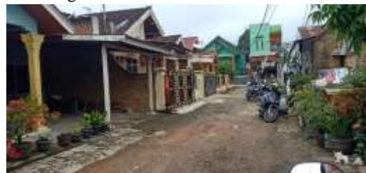
Gambar 5 Tipikal perumahan BTN Sungai Ulak tanpa Wet Floodproofing .
