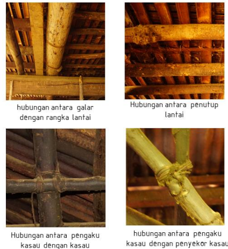
Gambar 3 Hubungan ikat pada komponen konstruksi bagian bawah Ghumah Baghi dan bagian atas
