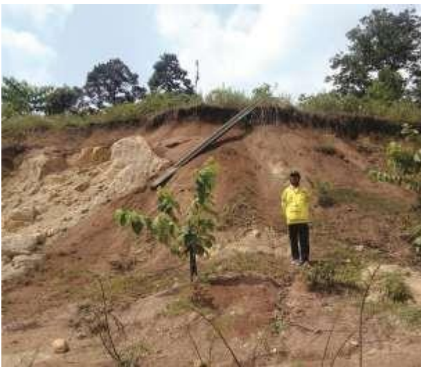
Gambar 6. Longsor waspada pada Lp 9 Desa Parakenbeusi
