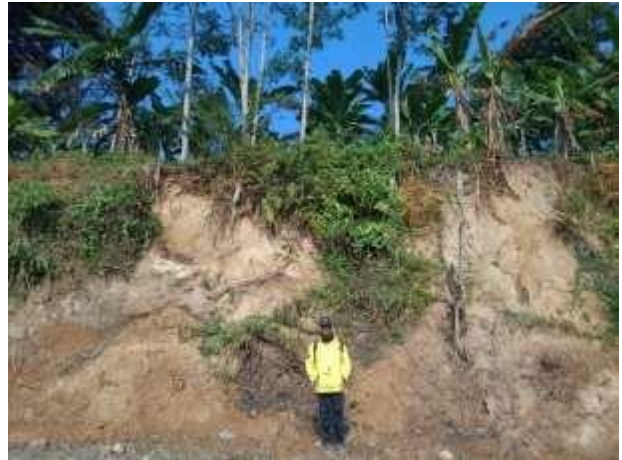
Gambar 7. Longsor yang stabil pada Lp 10 Desa Bojongan
