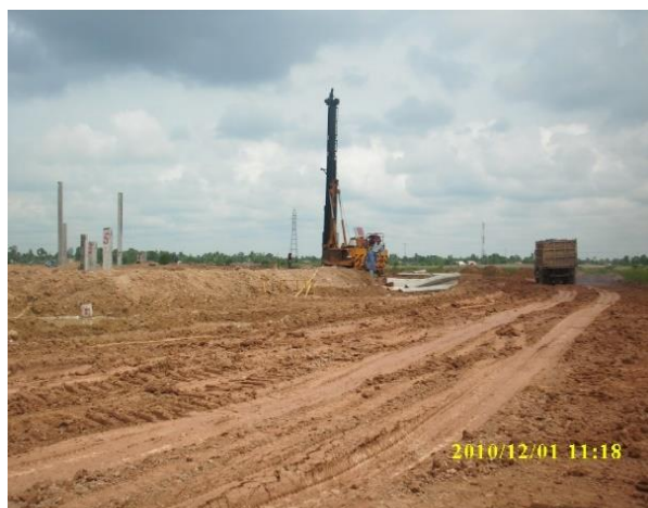
Gambar 2. Proses tahap pemancangan
