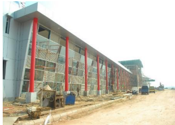
Gambar 3. Pelaksanaan Pembangunan Lapangan Tembak Bagian Depan
