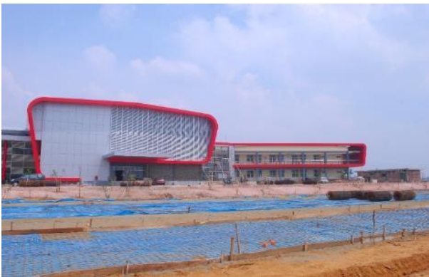
Gambar 2. Pelaksanaan Pembangunan Lapangan Tembak
