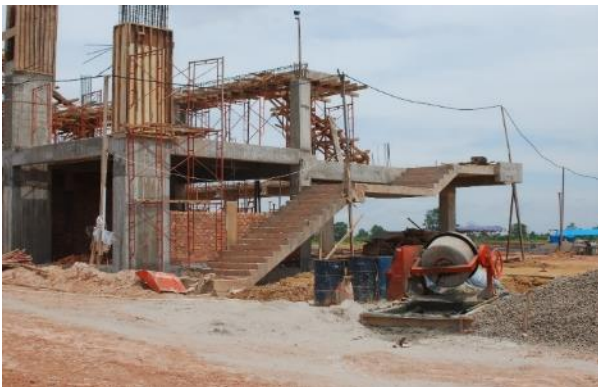
Gambar 9. Pelaksanaan Pembangunan Tribun
