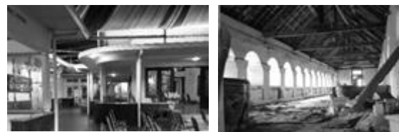
Gambar 9. Kiri, Kolom beton bulat penyanggah dak beton di teras yang melengkung. Kanan, bangunan loteng menggunakan konstruksi kuda-kuda kayu. Sumber: dokumen pribadi 2021
