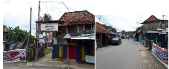
Gambar 6. Gambaran umum kondisi lokasi kantor Kelurahan 29 Ilir dan Kondisi jalan Gede Ing Suro Palembang (Dokumentasi 2021)
