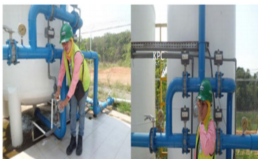
Gambar 3 Pemanfaatan Air Void Tambang Batubara Untuk Air Baku dengan Tehnologi WTP 300 di PT Adaro Indonesia.
