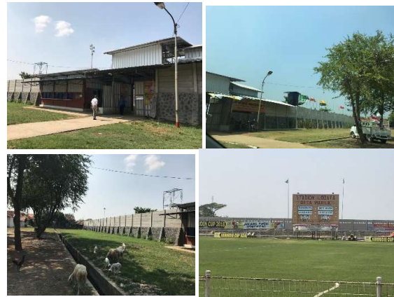
Gambar. 6. Kondisi Eksisting Stadion Sepak Bola Lodaya
