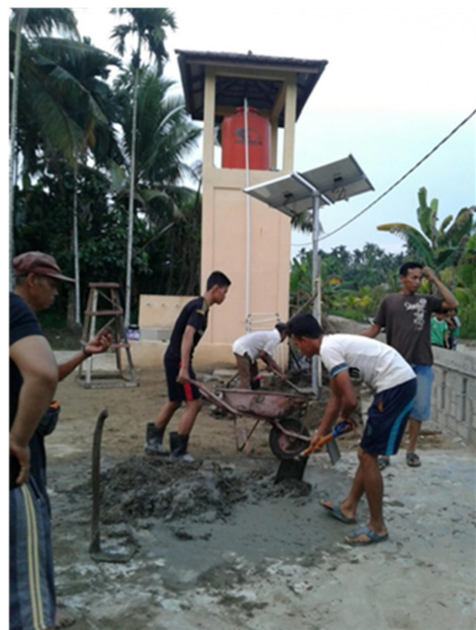
Gambar 5. Warga RW-06 sedang bergotong royong memasang tiang penyangg panel surya
