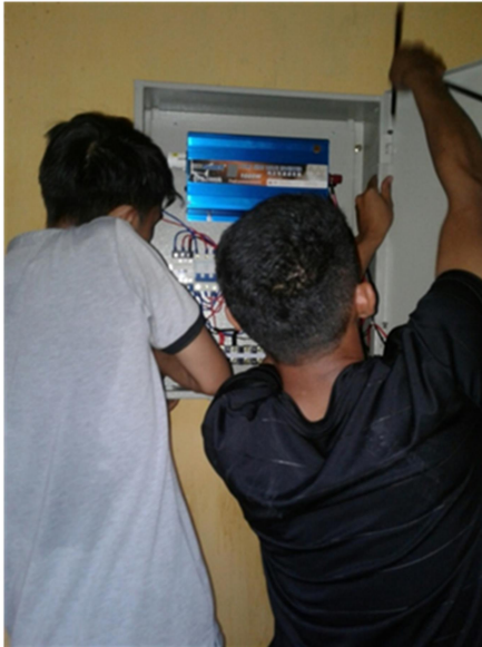
Gambar 6. Mahasiswa-mahasiswa Jurusan Teknik Elektro UNRI sedang memasang panel kendali sistem pompa air bertenaga surya
