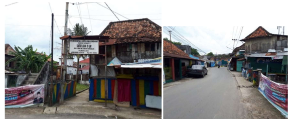
Gambar 4. Gambaran umum kondisi lokasi kantor Kelurahan 29 Ilir dan Kondisi jalan Gede Ing Suro Palembang (Dokumentasi 2020)
